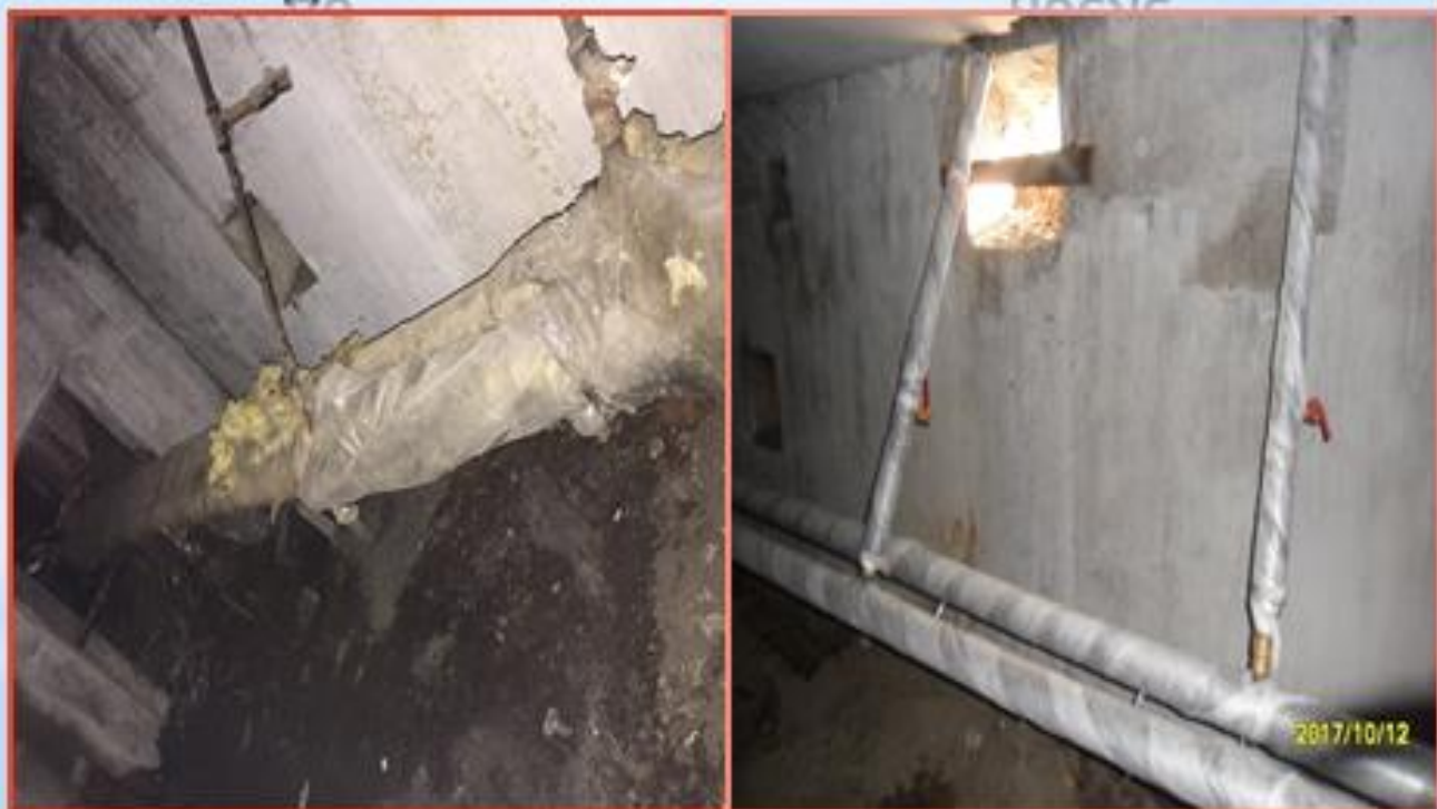
Ремонт внутридомовых инженерных систем
