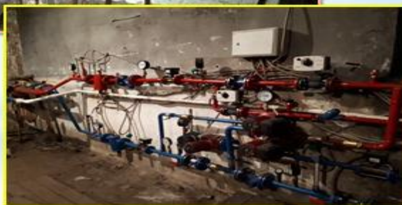
Устройство индивидуально-теплового пункта и установка общедомовых приборов учета
