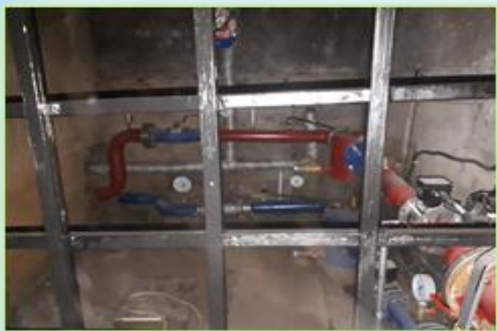
Устройства индивидуального теплового пункта и установка общедомовых приборов учета
